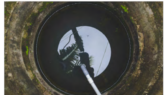
Freigelegte Trinkwassertrasse bzw. Schachtzugang
