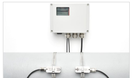
Auf der VAVA II wurden elf KATflow 100-Durchflussmesser installiert
